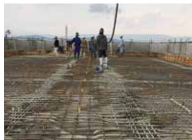
企業様寮新築工事
