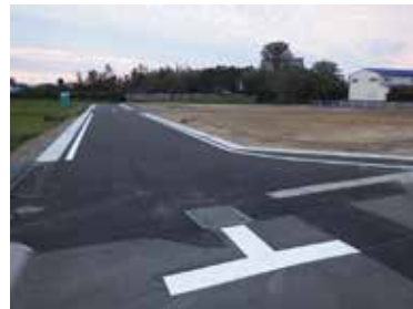
不動産様宅地造成工事
